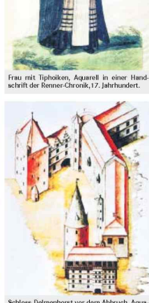
Schloss Delmenhorst vor dem Abbruch, Aquarell des Ingenieurkapitäns Hornigk, 1712.
