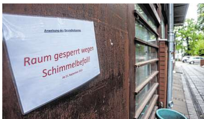
Wegen Schimmelbefalls und Gesundheitsgefährdung gesperrt: die Sanitär- und Umkleieräume des Blumenthaler Sportvereins auf der Sportanlage Godenweg. Die Sportdeputation berät nun über eine Lösung.
